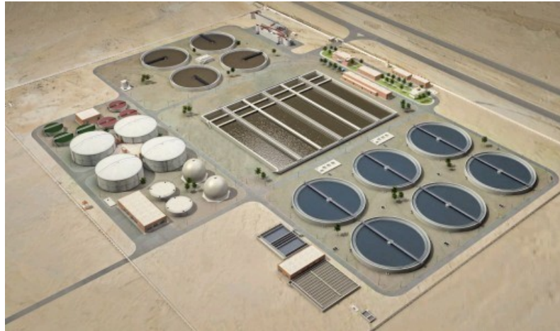
Maqueta en 3D de la futura estación depuradora de aguas residuales de New Cairo.
